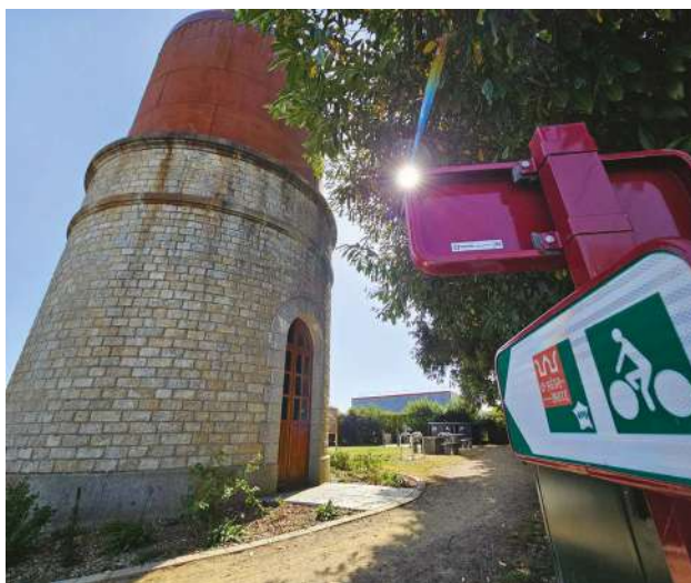
La Régalante à Saint-Brice-en-Coglès-Maen Roch et son château d'eau ferroviaire maçonné, l'un des derniers du département voire de France (1872) ©TC_CMDB
