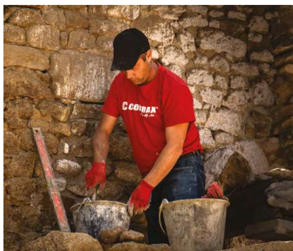
Chantier de restauration du patrimoine à Chauvigné ©EDILUZ
