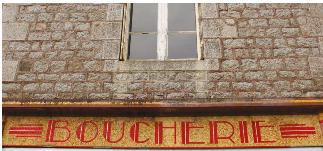
Facade de la boucherie Sausset, enseigne en mosaïque, maison Odorico, Saint-Hilaire-des-Landes ©TC, CMdB
