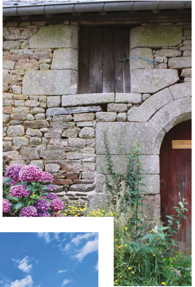
Un habitat granitique à Noyat-sous-Bazouges ©TC, CMdB
