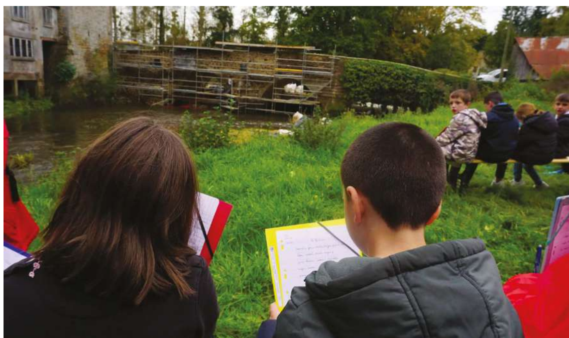
Médiation jeunes publics autour du chantier de restauration du pont du Couesnon (2024) ©APPAC
