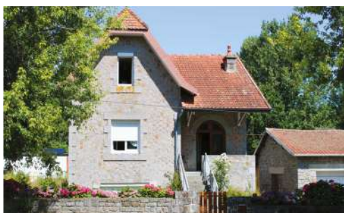
Habitation du début du XX e siècle de style villa balnéaire, Chauvigné ©TC_CWdB
