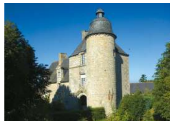
Ancien manoir de la Vieuville, Le Châtellier ©Région Bretagne, Inventaire du patrimoine, N. Lambert, 2010 ©TC_CMdB
