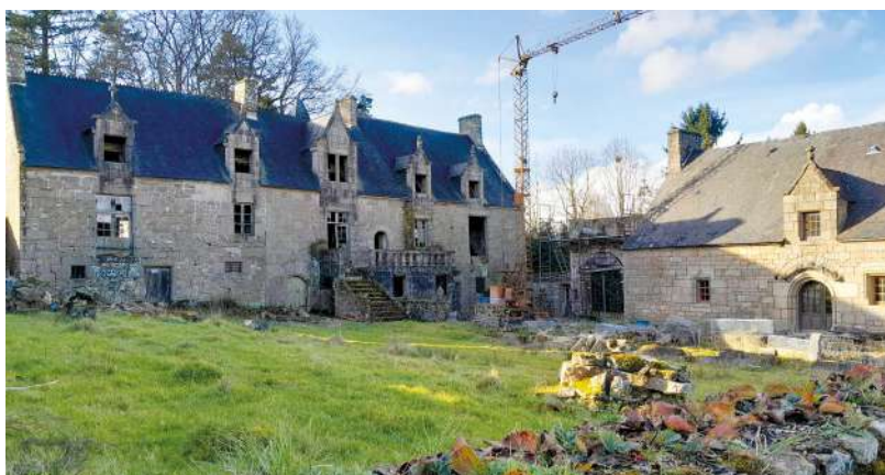
Le manoir de Bonteville à Montbours qui nécessite une importante campagne de restauration ©TC_CMDB
