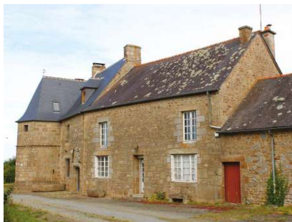
Habitat rural au linteau de porte orné d'une accolade panachée et à fleuron à Saint-Hilaire-des-Landes ©TC_CMdB
