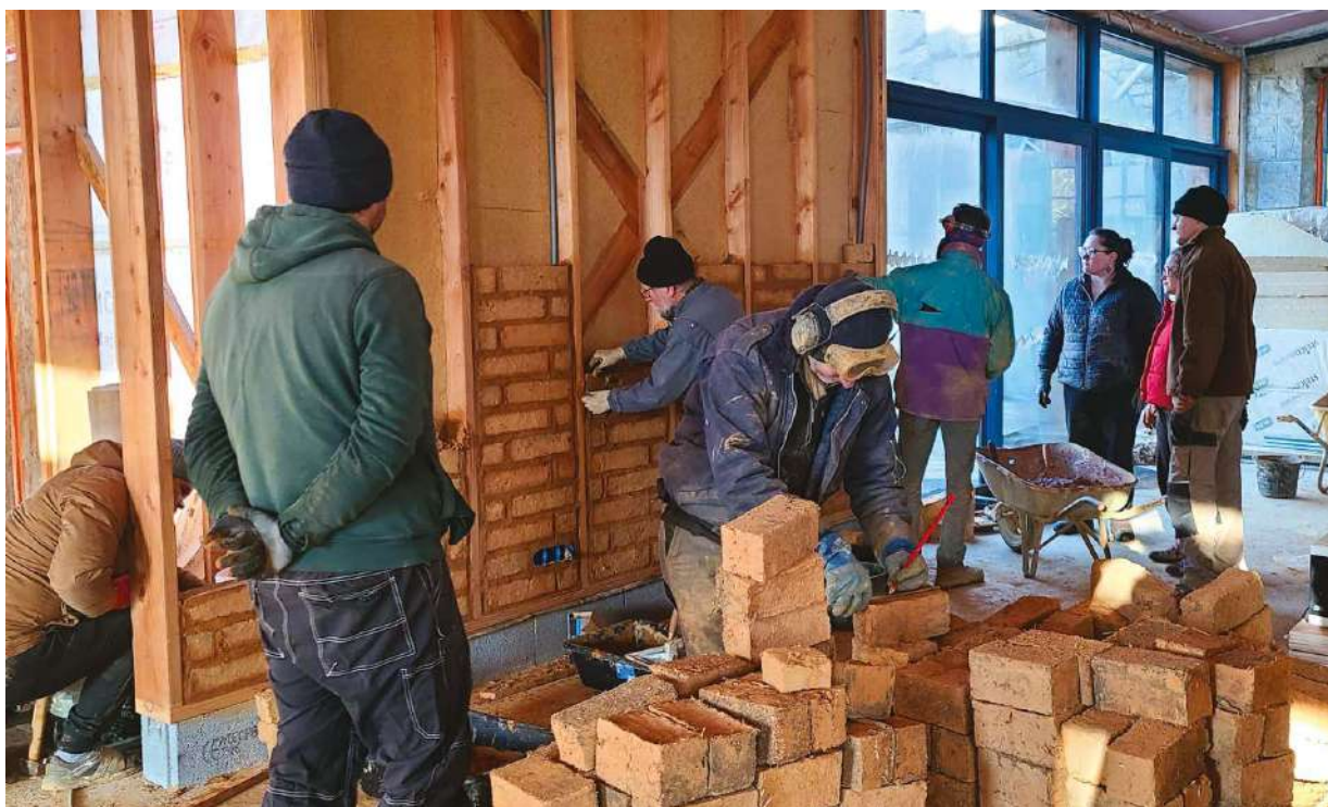
Montage des murs en terre de la médiathèque de Bazouges-la-Pérouse en présence de bénévoles © Pôle CLP_CmDB
