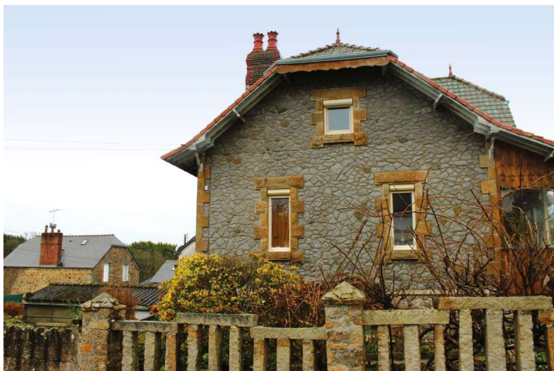
Maisons du quartier ouvrier de la Chaperonnière, Antrain (Val-Couesnon) ©TC, CMdB
