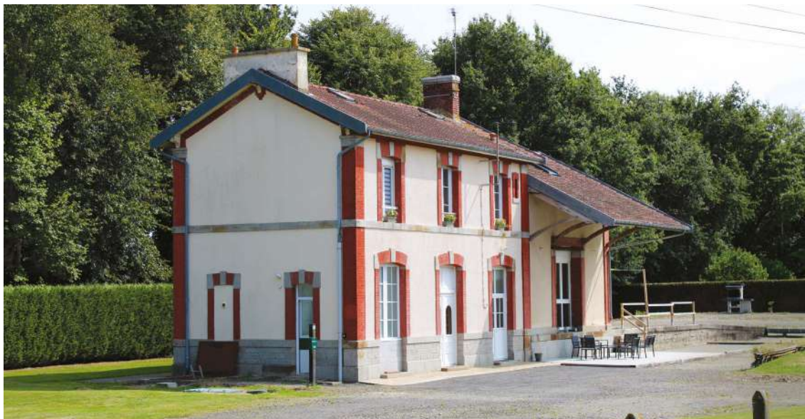
Ancienne gare, Saint-Germain-en-Coglès ©TC_CMdB
