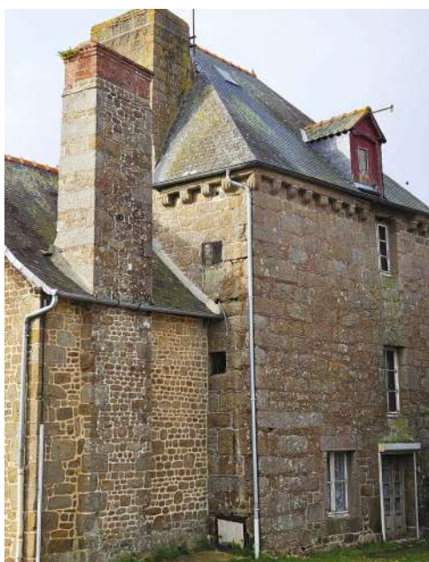
Demeure urbaine à corniche modillonnée, Saint-Hilaire-des-Landes ©TC_CMDB
