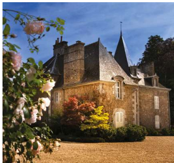
Château de Maison Neuve (Chauvigné) ©EDILUZ
