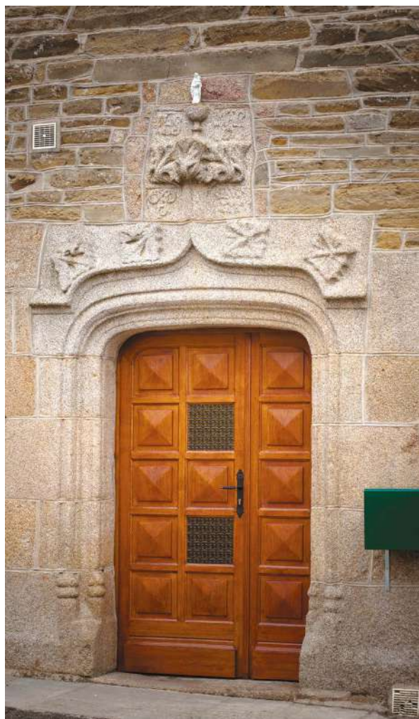
Porte de la maison de bourg datée de 1530 à Rimou ©STEN DUPARC
