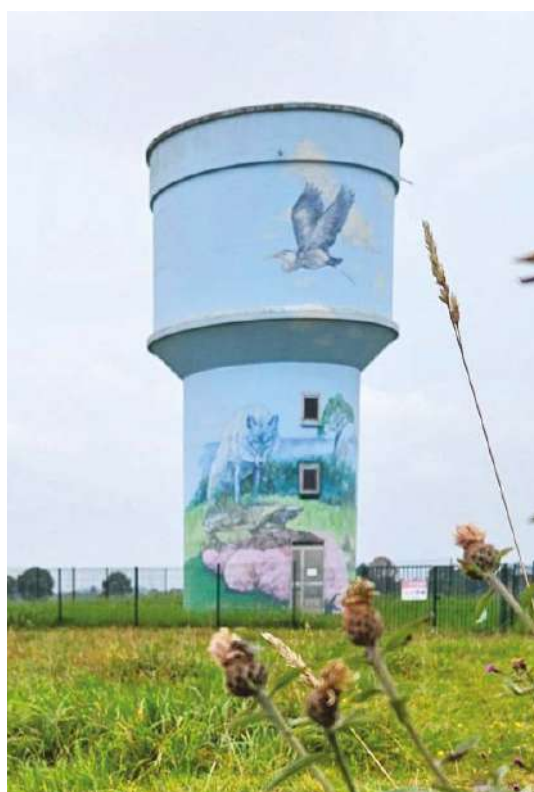
Château d'eau de Cogles © TC, CMdB
