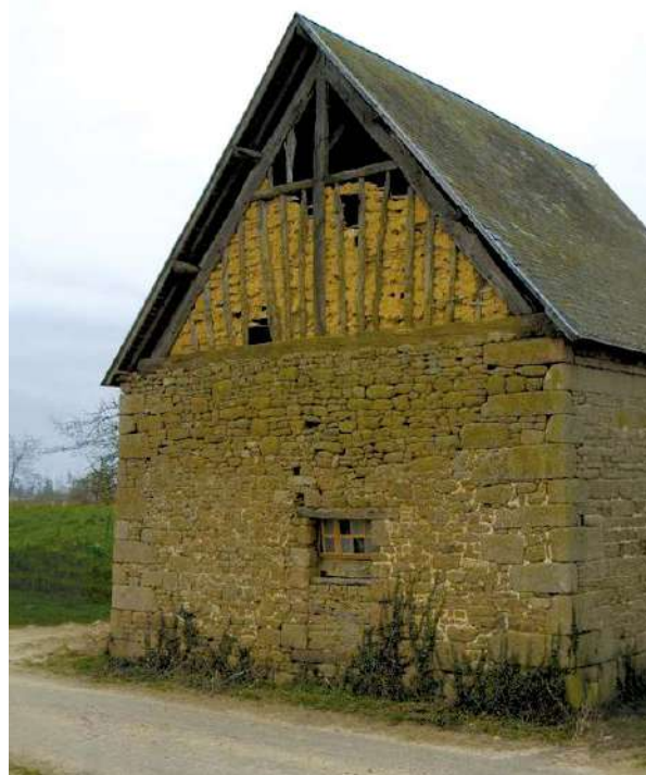
Écart d'Aubigné (Coglès), pignon à pan de bois hourdis, 18 e s. ©Région Bretagne, inventaire du patrimoine, N. Lambert, 2011
